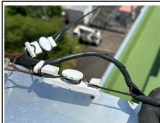
・7月15日（月）道徳 クロージャー付近で強く曲げ られて、光芯線が折れている。
